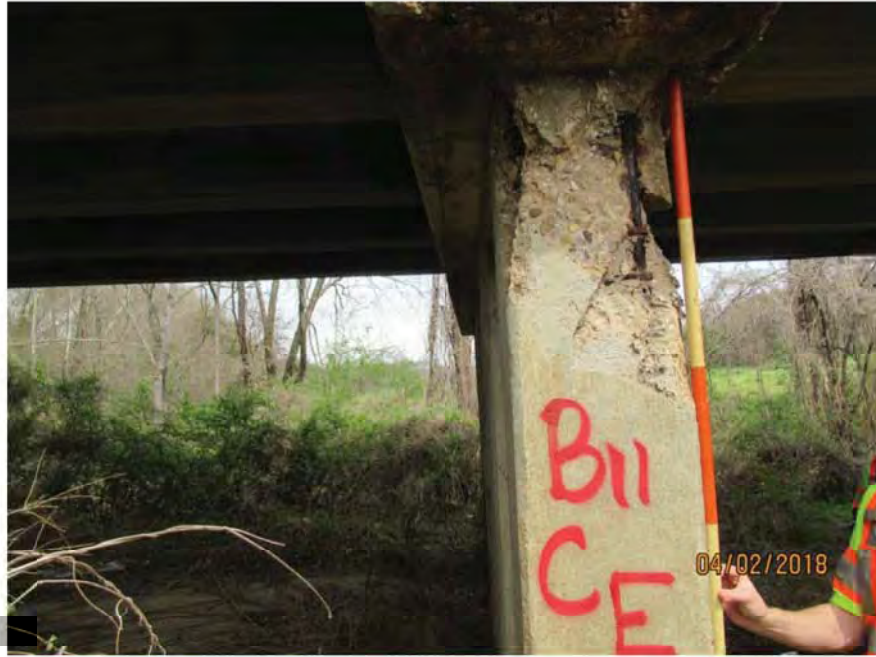
BENT 11 - COLUMN E
